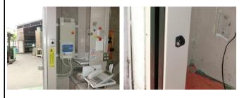
●開閉をリモコン式に変更予定。今のクイックは **目玉センサー**に変更になっているため、光電SWカバーが 無くなってます。部品の注文が減った・・・(泣)
